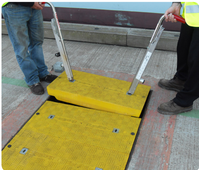
Krycí desky o nosnosti F900 nainstalované v největším přístavu Spojeného království
